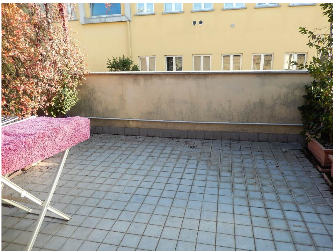
Foto 16 – Il terrazzo sul lato sud.
